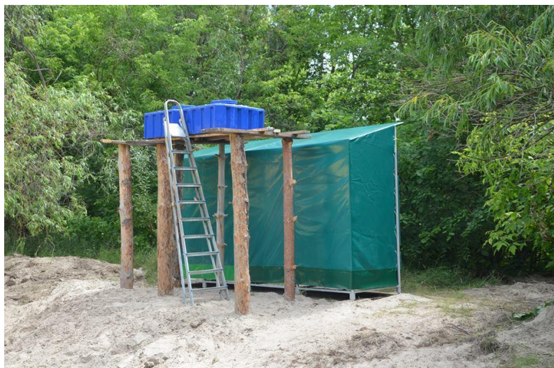
Рис.8 Душова кабіна з постачанням води з баків
